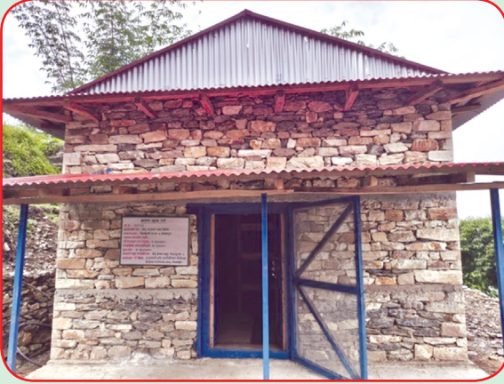
रष्ट्रिक स्टोर निर्माण चिशंखुगढी गा.पा.-८, ओखलढुंगा
