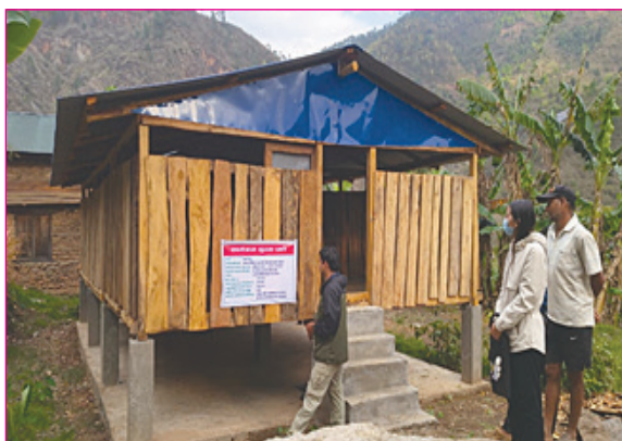
उन्नत प्रविधि बाखा खोर निर्माण सिद्धिचरण न.पा. १, (तुलवा) ओखलढुंगा
